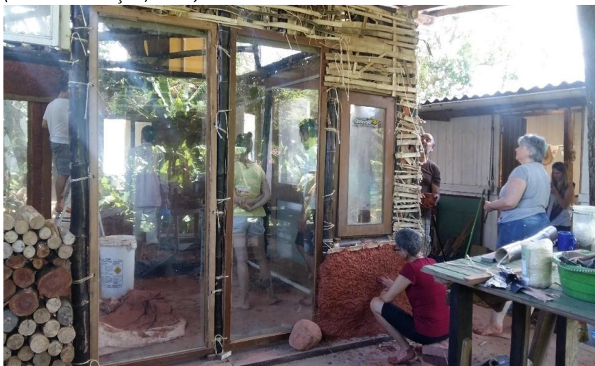
Figura 7: Bioconstrução sendo feita com a participação da comunidade (Fonte: Conceição, 2022).
