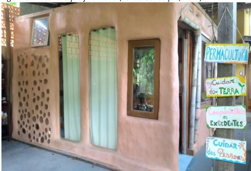
Figura 8: Bioconstrução finalizada (Fonte: Conceição, 2022).
