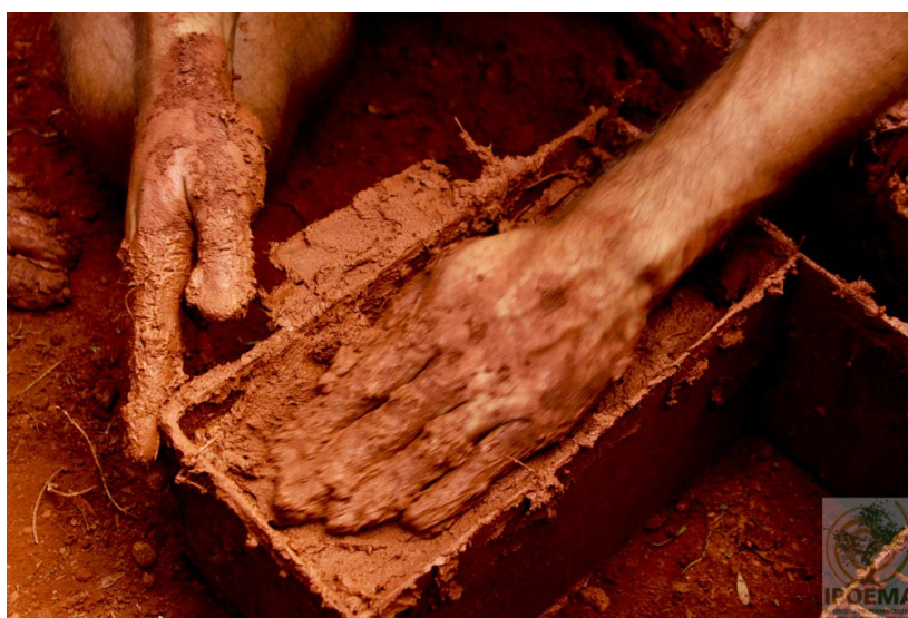
Figura 4. Bioconstrução com técnica adobe. Fonte: IPOEMA.
